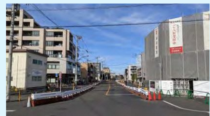
写真：東小金井駅北口の区画整理の様子 (令和3年11月時点)
