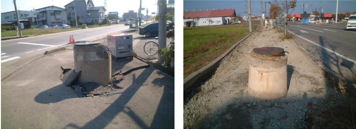
図4-5 マンホール浮上状況(2004年 新潟県中越地震)
