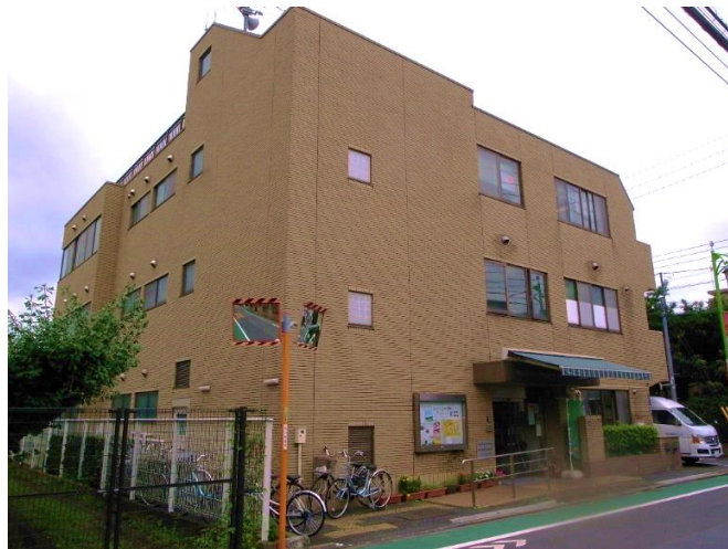
図 1 センターの外観写真
