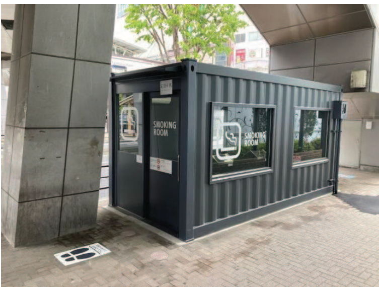
立川駅南口公衆喫煙所
